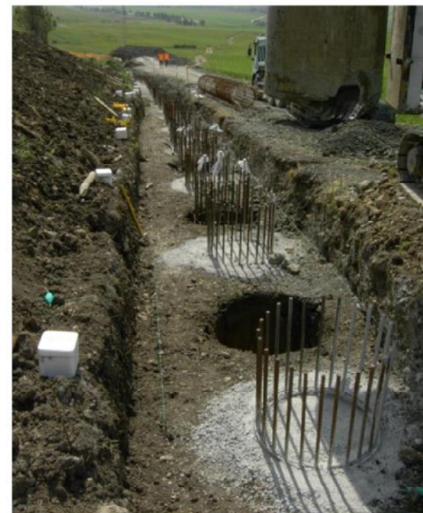
A16 km 124+700 Ovest Evidenze del dissesto Paratia di pali tirantata
