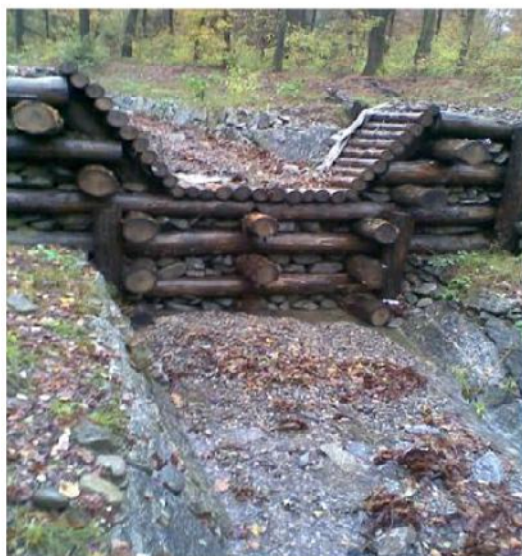
A08DIR GALLARATE – GATTICO Sistemazione sbocco opera minore al Km 22
