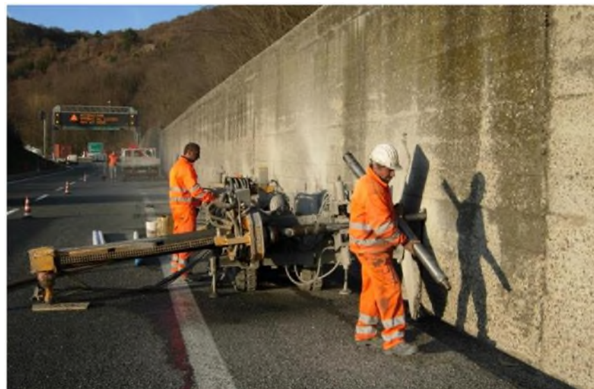
Realizzazione dreni microfessurati su muro esistente
