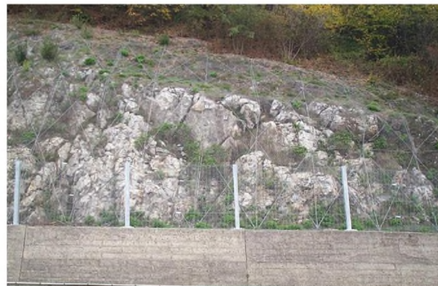
Schema rete con rafforzamento corticale – difesa attiva
