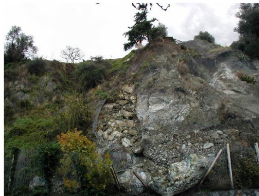
Pareti in roccia con distacco materiale lapideo
