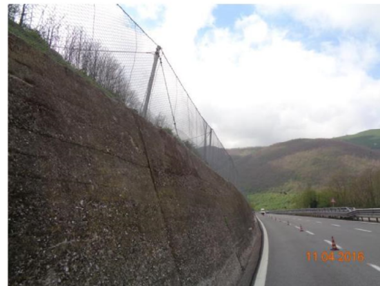
Schema barriera paramassi fissa – difesa passiva
