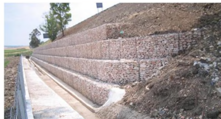
Dissesto rilevato e ripristinato con struttura di sostegno in gabbioni
