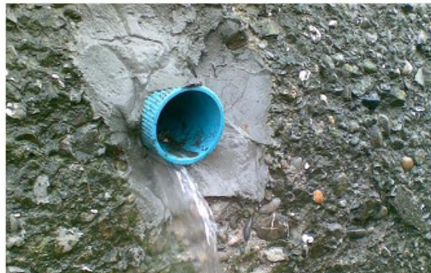
Realizzazione dreni microfessurati su muro esistente
