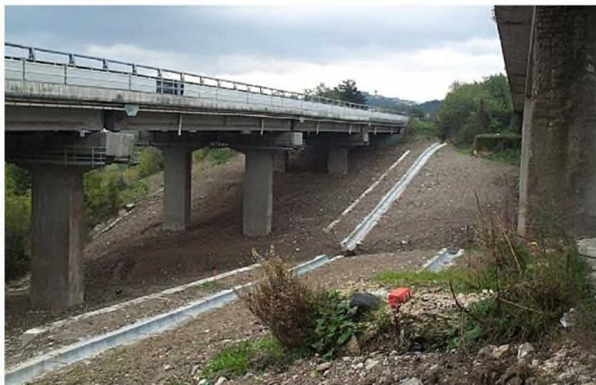
Regolazione idraulica superficiale Fuoriuscita acqua di drenaggio
